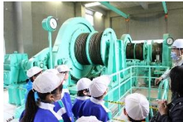
↑ 取水塔内部の見学
